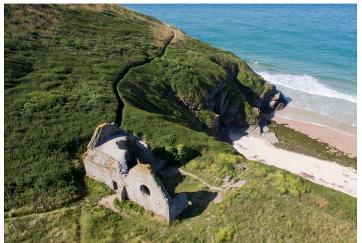
La vieille église est classée MH (janvier 1942)
