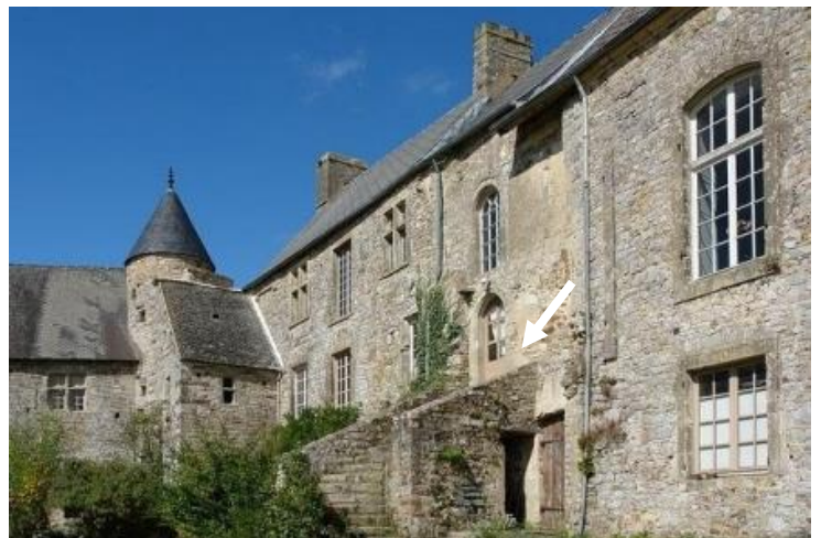
En lieu et place de cet escalier il y avait une tour escalier
