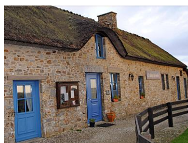
L'auberge avec toiture en chaume
